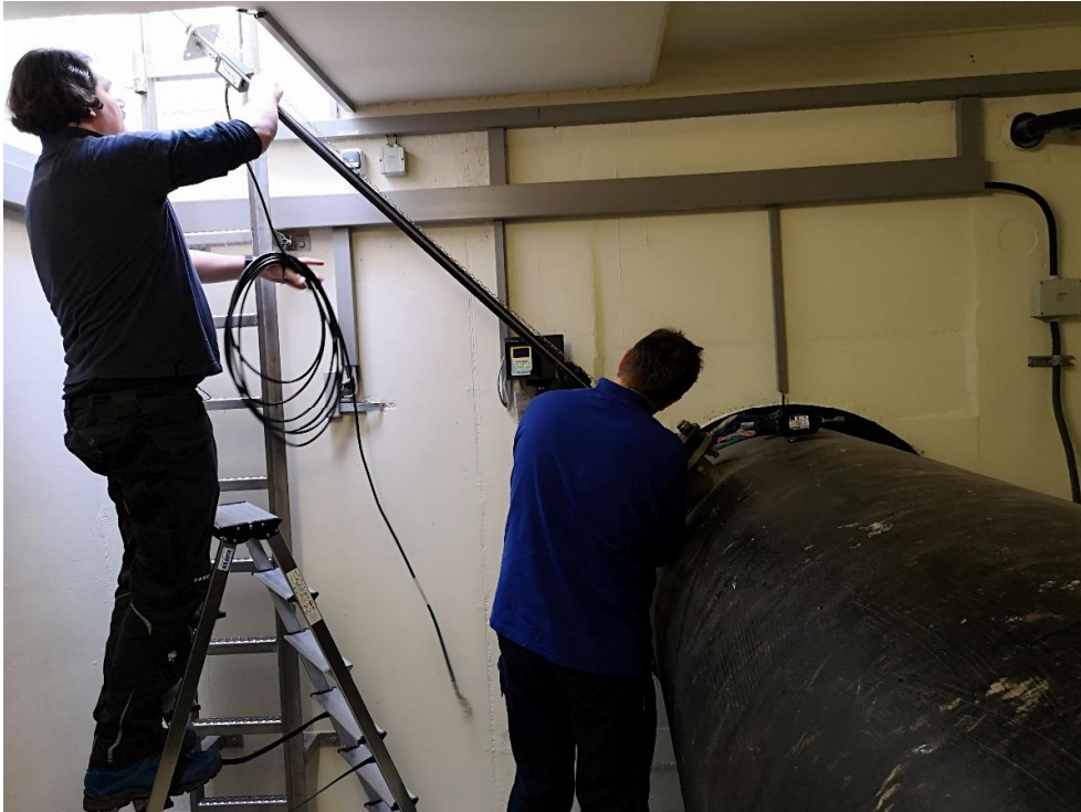
Bild 6: Montage AVI-MAG™ Lanzen-MID DN 1000 durch Kugelhahn, ausgeführt durch zwei Mitarbeiter der GWU-Umwelttechnik GmbH
