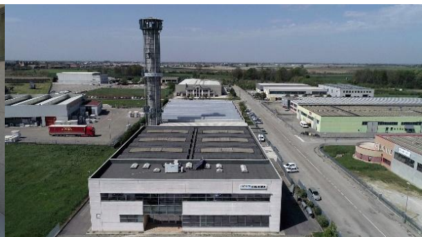
Bild 4: Wasservorhaltung 44m Turm
