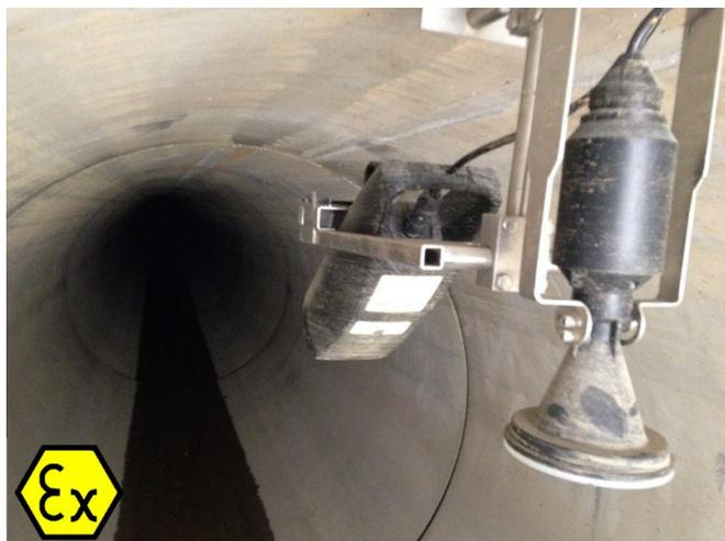
Abb. 2: Kombinierte Sensoreinheit im Kanal
